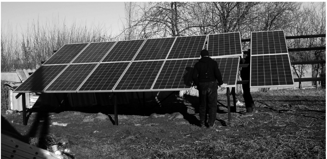
Сонячна електростанція ДНЗ «Сонечко»
